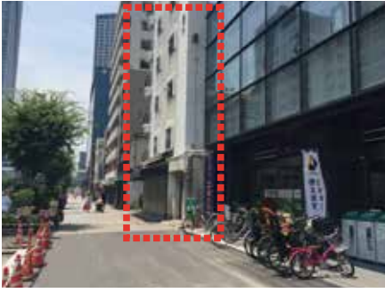
④建物付近。東武ストアの隣の古いマンションです
